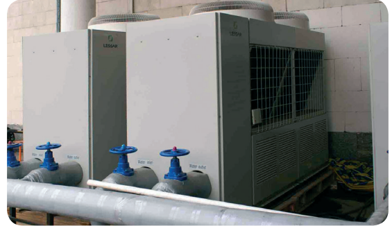
A LED-ek által melegített színpadburkolatot hűtő rendszer
